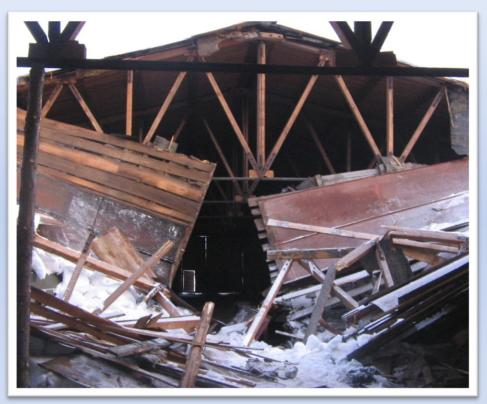
февраля 2010 года в ОАО «Афанасьевский мелиоратор» действием снеговой под нагрузки произошло обрушение пролёта крыши здания стоянки. В это время водитель, занимавшийся подготовкой автомобиля к выезду на линию, был придавлен обрушившимися фрагментами крыши, получив при этом тяжелую травму.
